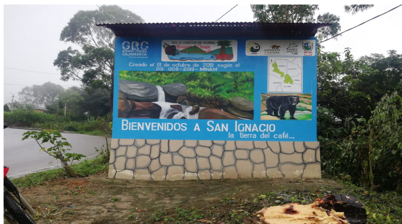
Figura 27. Colocación de murete, ACR- BCHCCH
