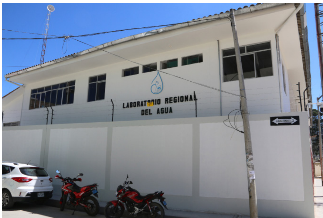
Figura 271: Infraestructura del Laboratorio Regional del Agua
