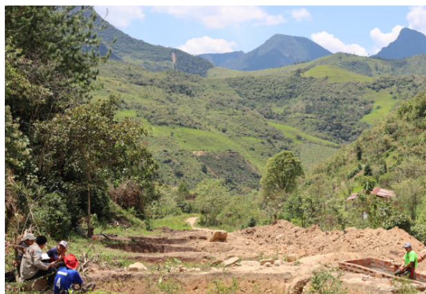
Figura 112. Construcción de pozas.
