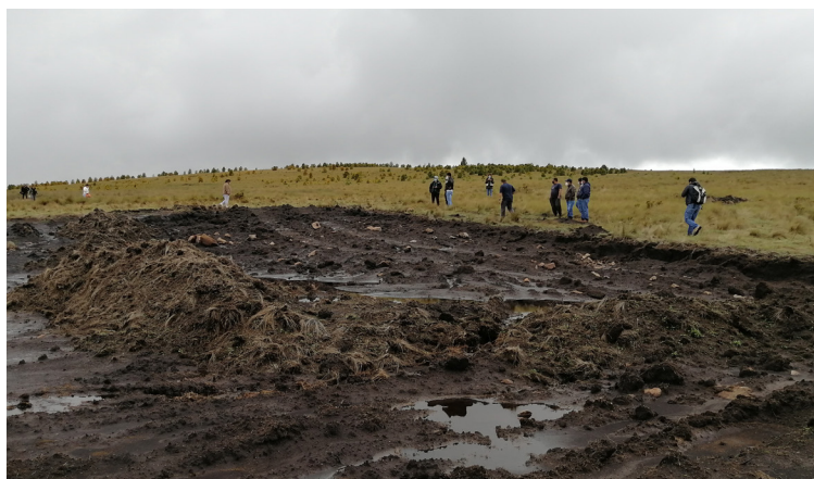
Figura 216. Extracción de suelos orgánicos.
