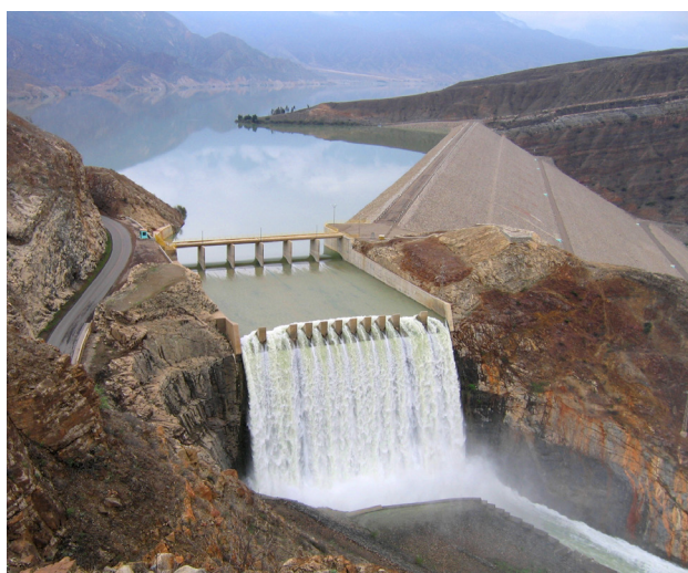
Figura 190. Zona aprovechamiento - Infraestructura Hidraulica Mayor - PEJEZA
